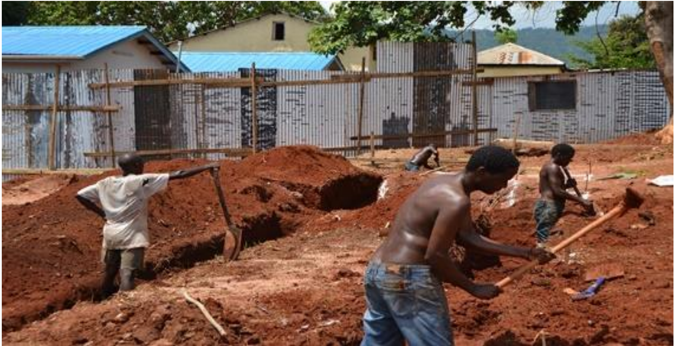
Mafundi wakiendelea na kazi ya ujenzi wa wodi ya kisasa ya wanawake
