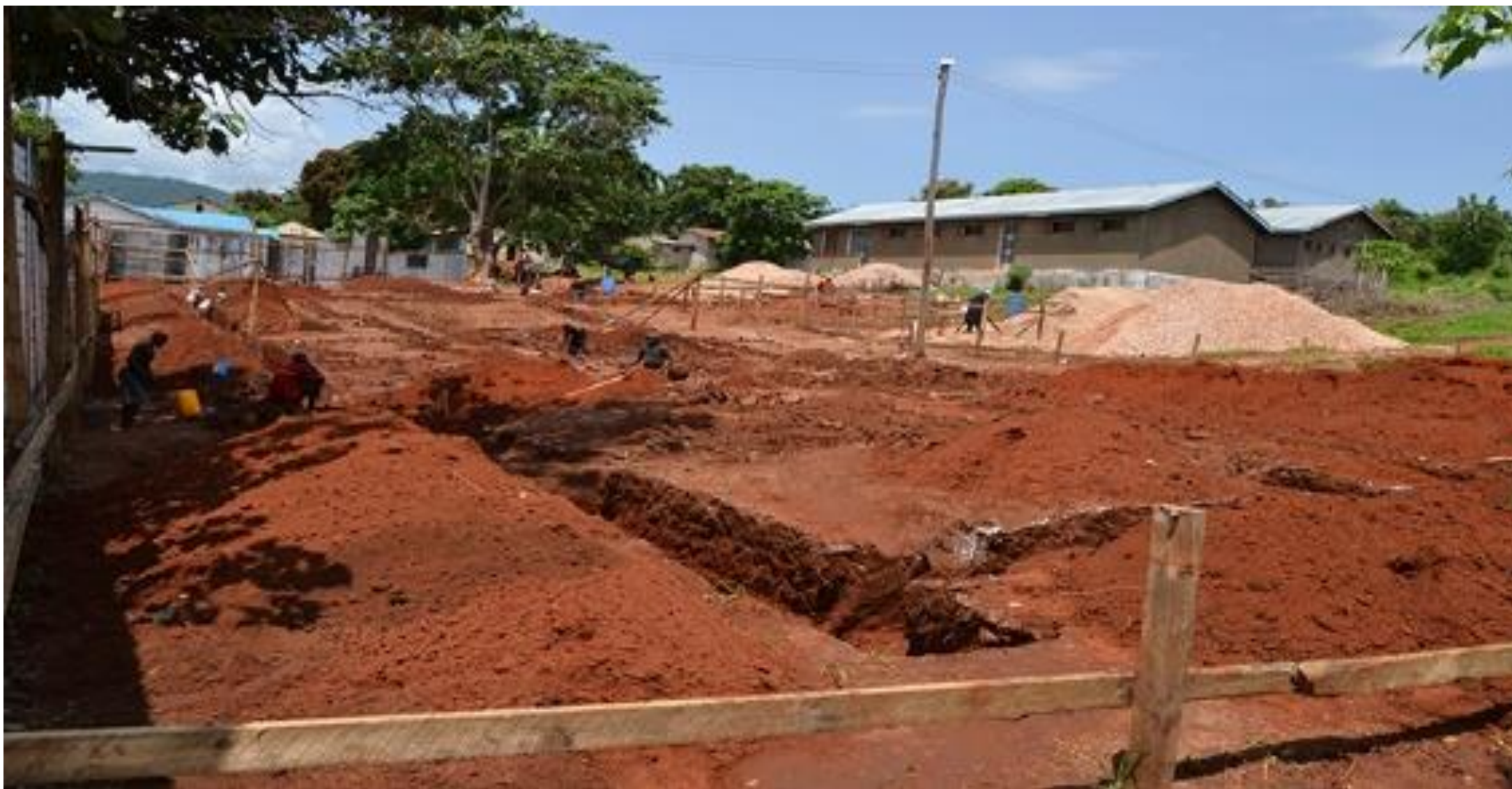
Mafundi wakiendelea na zoezi la ujimbaji msingi wa jengo la wodi ya wazazi
