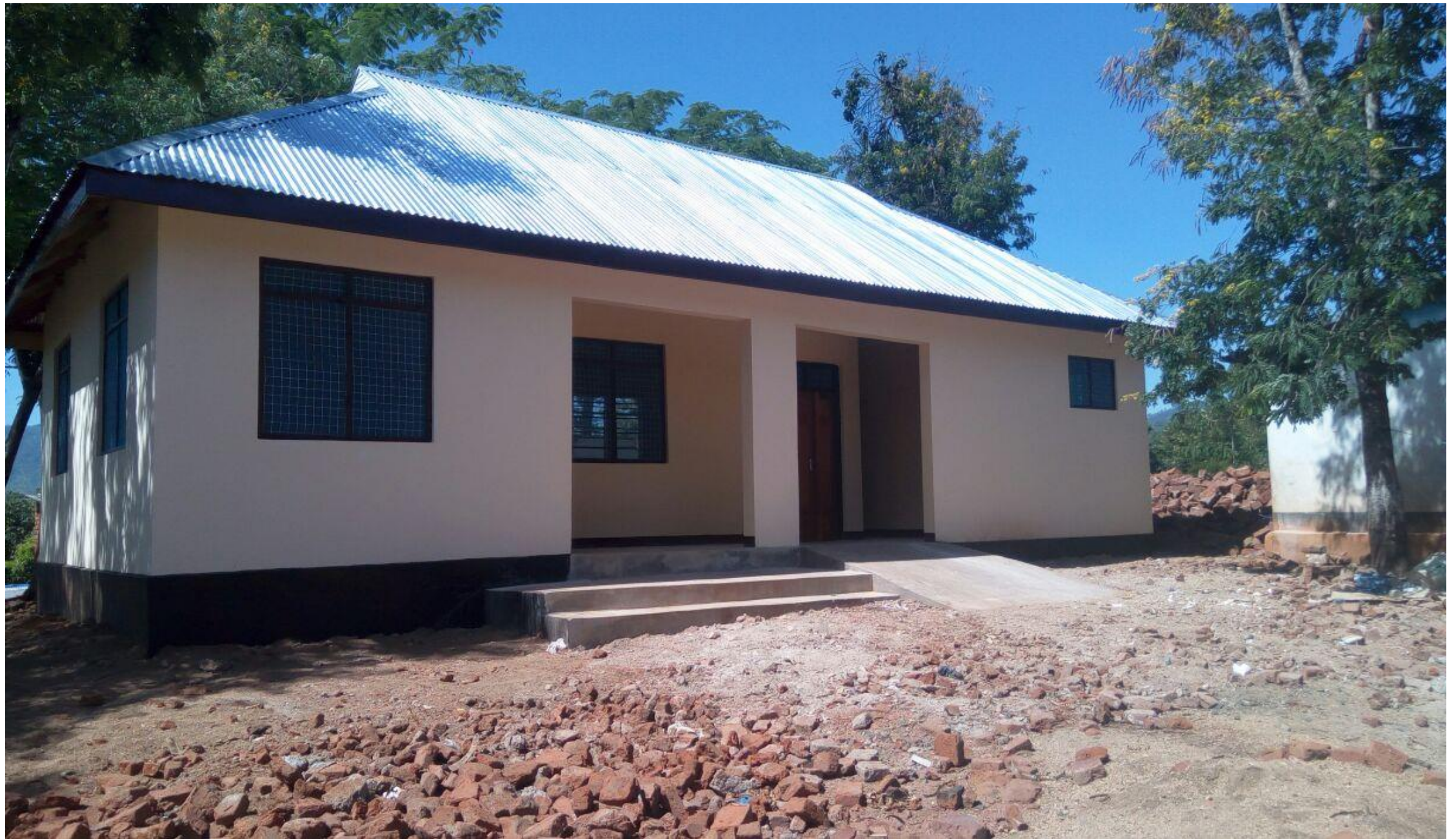
Mradi wa ujenzi wa jengo la ofisi ya kijiji cha Msimba Mikumi ukiwa umekamilika
