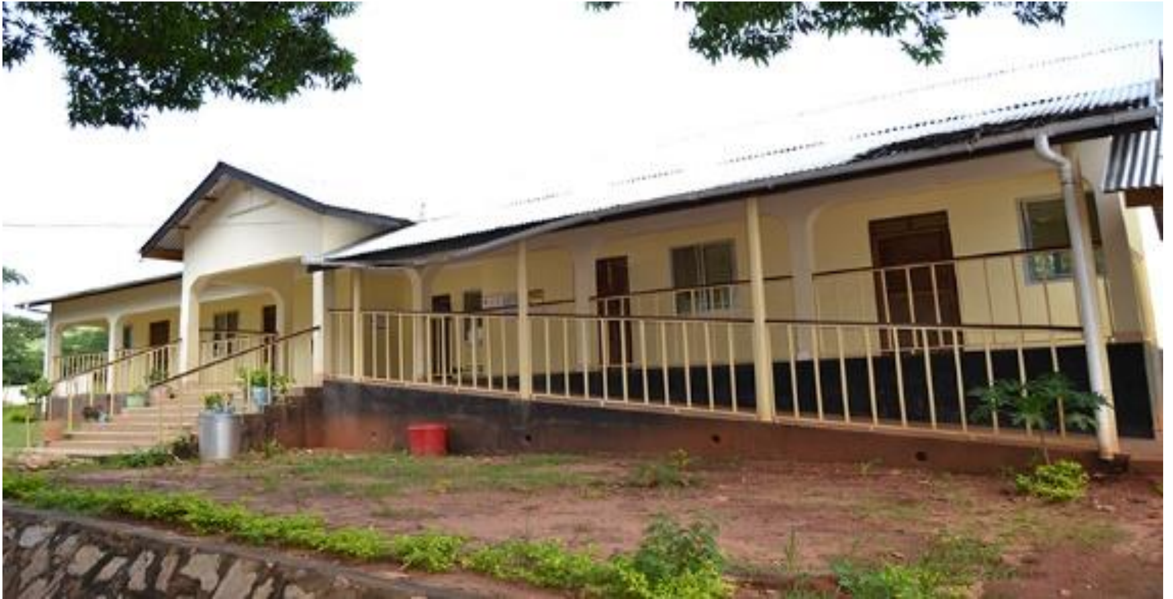
Mradi wa ujenzi wa wodi ya daraja la pili ukiwa umekamilika katika hospitali ya Wilaya kilosa
